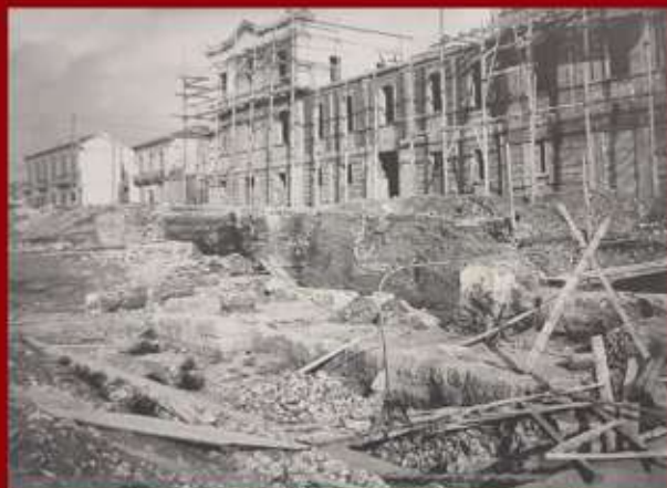
Il cantiere delle mura greche di via Marina (Archivio SABAP RC)
