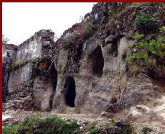
Le abitazioni in grotta su cui è fondato l'abitato medievale
