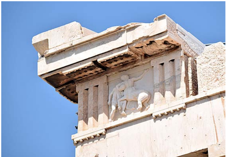
Foto 8: Particolare della trabeazione del Partenone, ad Atene, con due triglifi e una metopa.
